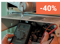
Contrôles réglementaires & sécurité incendie
