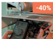
Contrôles réglementaires & sécurité incendie
