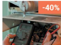
Contrôles réglementaires & sécurité incendie
